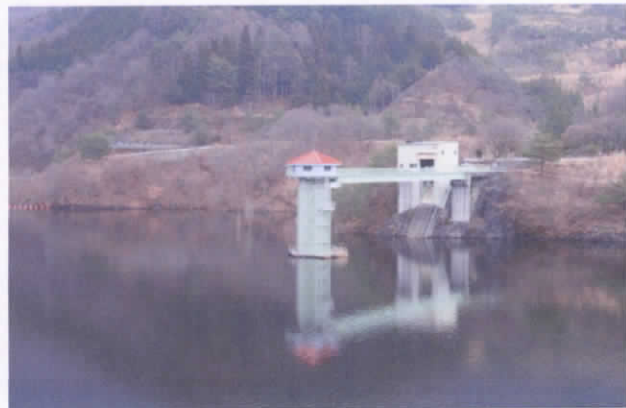
荒川ダム取水塔
